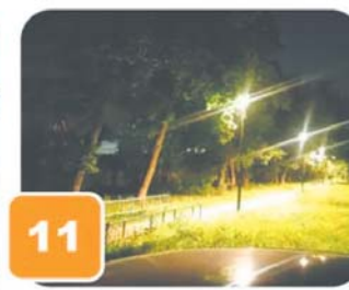
Устройство новых объектов наружного освещения
