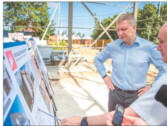
На строительной площадке здравпункта в селе Дубки работают порядка 30 человек: каменщики, кровельщики, специалисты по металлоконструкциям и гидроизоляции / ФОТО ВАЛЕРИЙ ЖУКОВ
