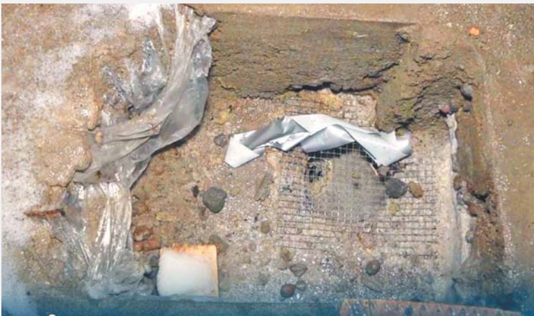
▲ Так выглядит вход в ливневую канализацию с крыши
