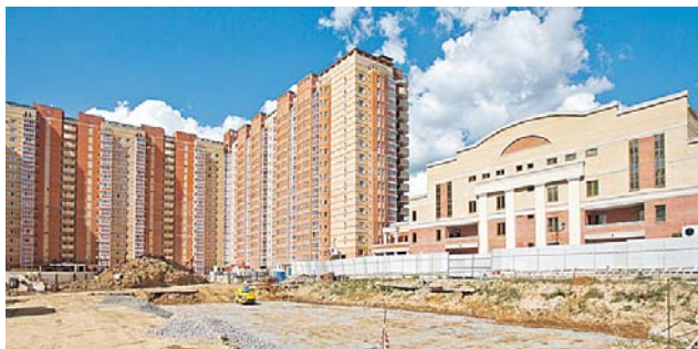
Строящийся детский сад п. ВНИССОК (Дубки) К-2 (котлован в центре)
