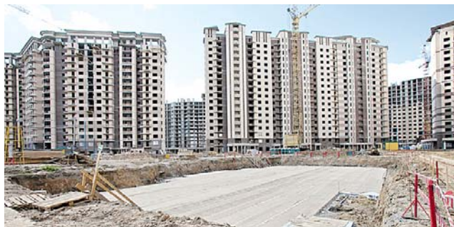
Детский сад на 110 мест - ул. Акуловская, уч.2ж, 2и (котлован)
